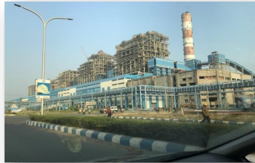
3x660 MW Barh STPP, NTPC
