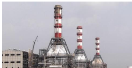
2x384 MW CCPP, Vemagiri, A.P.
