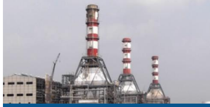
2x384 MW CCPP, Vemagiri, A.P.
