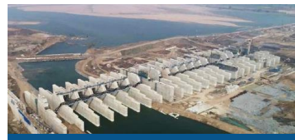
Medigadda Barrage, Telangana
