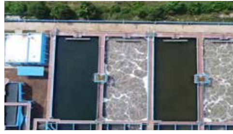
33 MLD STP, Anand, Gujarat
