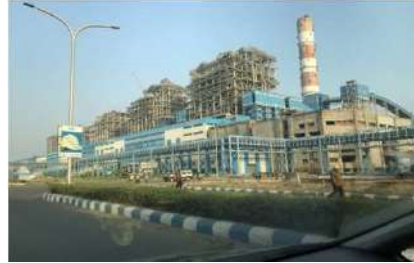
3x660 MW Barh STPP, NTPC
