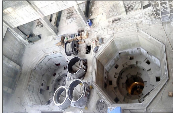
New Umtru H E Project
