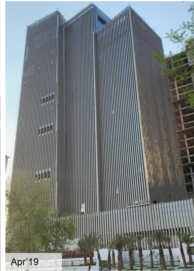
Actual site images of Max Towers
