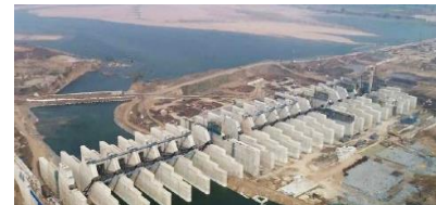
Medigadda Barrage, Telangana
