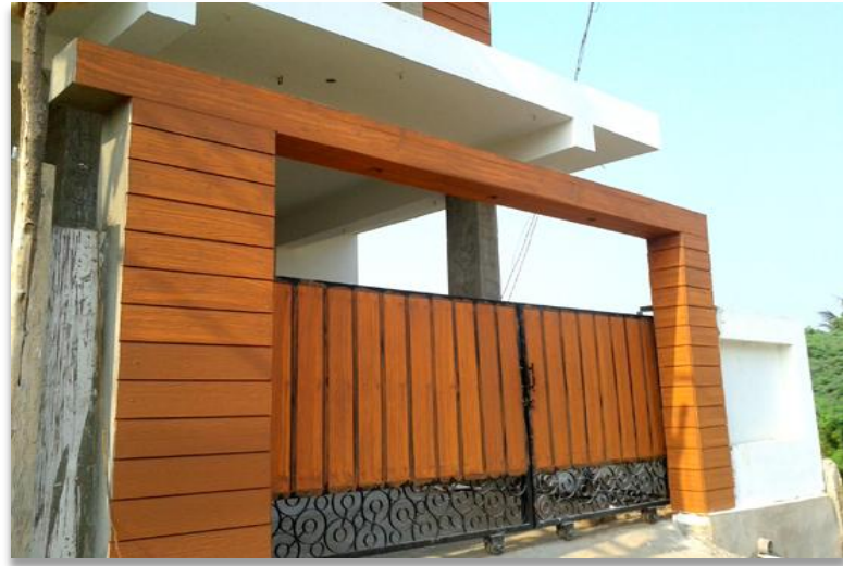
Gate Cladding - (V-Plank)
