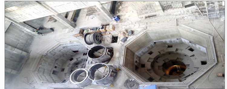
New Umtru H E Project
