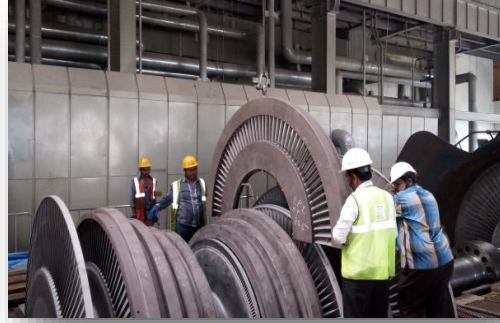
TG Overhauling 600 MW Jharsuguda Vedanta
