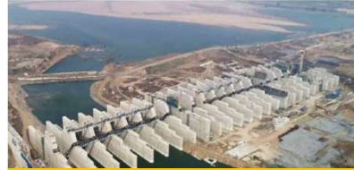
Medigadda Barrage, Telangana
