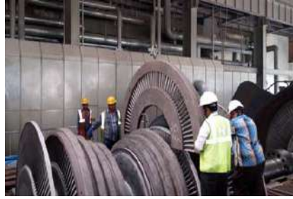
TG Overhauling 600 MW Jharsuguda Vedanta
