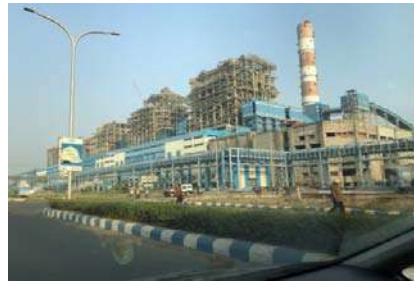
3x660 MW Barh STPP, NTPC
