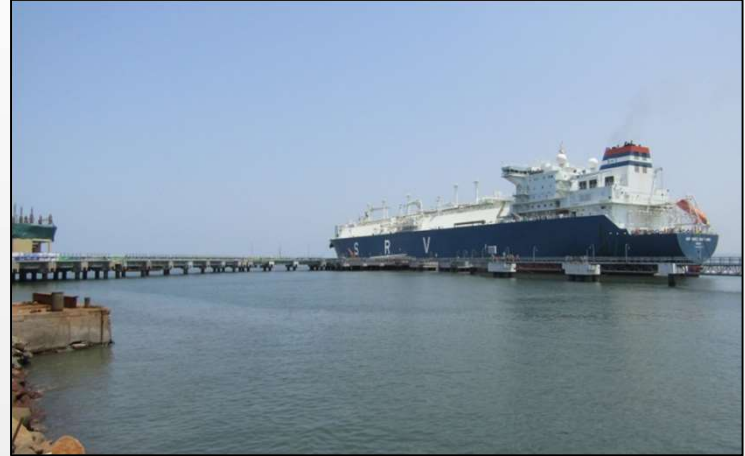
LNG Terminal for H-Energy, Raigad
