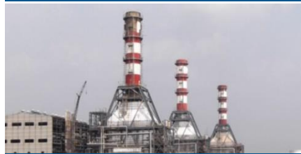
2x384 MW CCPP, Vemagiri, A.P.
