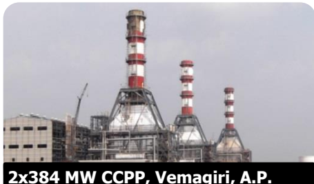
2x384 MW CCPP, Vemagiri, A.P.
