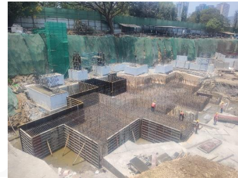
Tower (D) Raft work in progress
