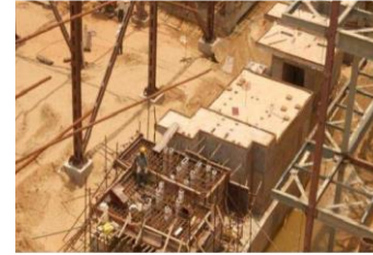
3X660 MW, STPP, STG,BOP ,NORTH KARNAPURA, BHEL
