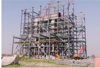
1X660 MW TPP, BTG, HARDUAGANJ, DOOSAN
