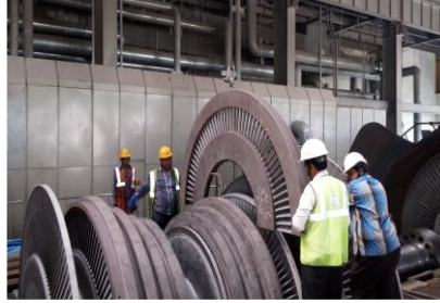
TG OVERHAULING 600MW JHARSUGUDA VEDANTA
