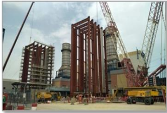
250 MW SABIYA CCPP, KUWAIT INSTALLATION OF HRSG
