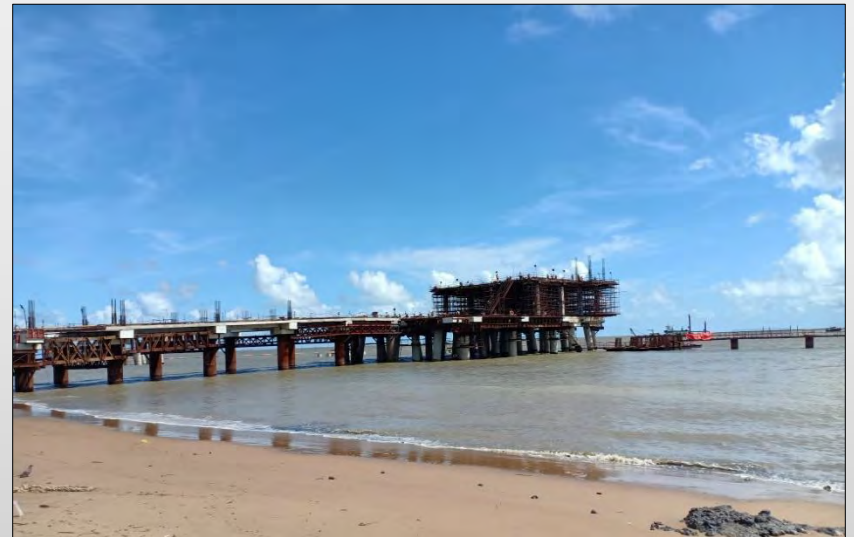
Dhamra, LNG Jetty, Orissa
