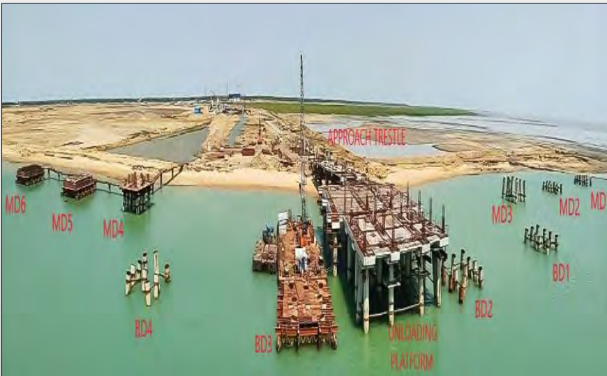
Dhamra , LNG Jetty, Orissa
