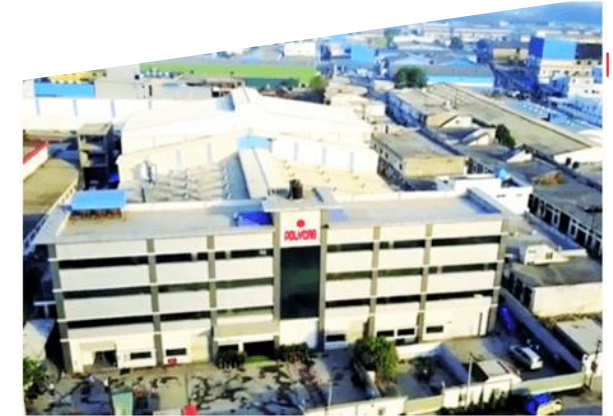
Fan Manufacturing Unit
