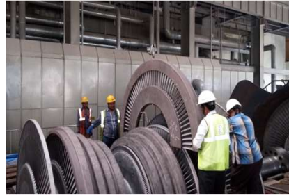
TG Overhauling 600 MW Jharsuguda Vedanta
