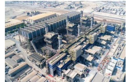
1800 MW Alba CCPP, ETC of GTG, STG, HRSG & BOP, Bahrain
