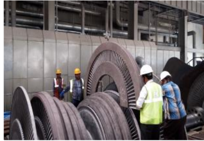
TG OVERHAUING 600MW JHARSUGUDA VEDANTA
