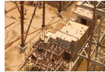
3X660 MW, STPP, STG,BOP ,NORTH KARNAPURA, BHEL
