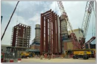
250 MW SABIYA CCPP, KUWAIT INSTALLATION OF HRSG
