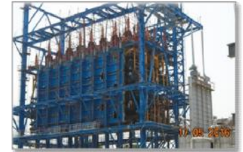
360MW BHERAMARA CCPP, BANGLADESH INSTALLATION OF GTG, STG & HRSG
