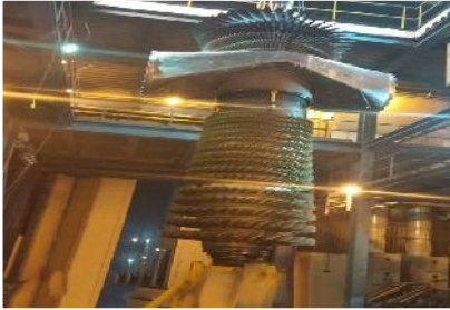
SIEMENS -138MW GAS TURBINE PAGUTHAN
