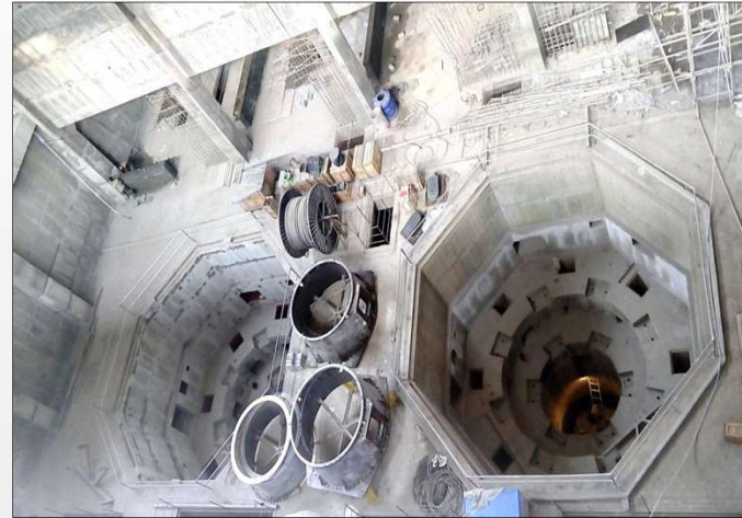
New Umtru H E Project
