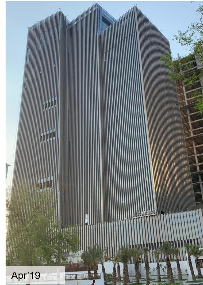
Actual site images of Max Towers
