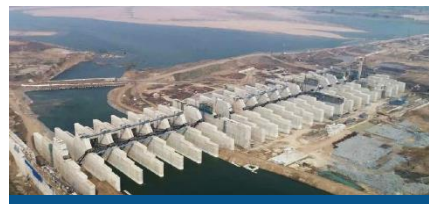
Medigadda Barrage, Telangana
