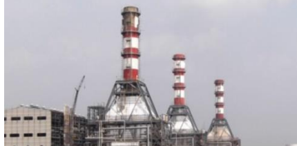
2x384 MW CCPP, Vemagiri, A.P.
