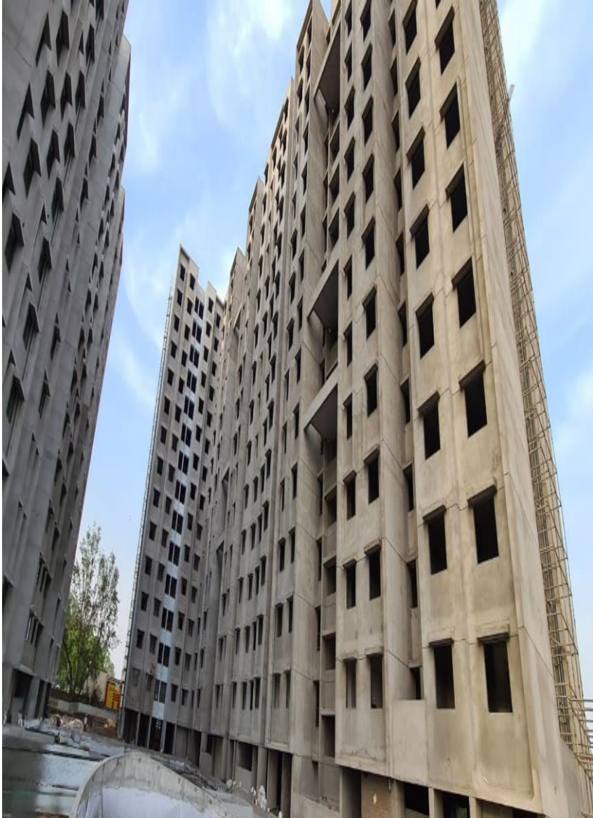
Actual Construction Images
