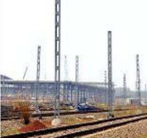
Tata Steel Plant – Kalinganagar (Odisha)
