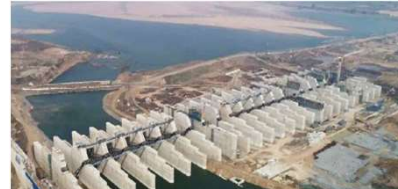
Medigadda Barrage, Telangana
