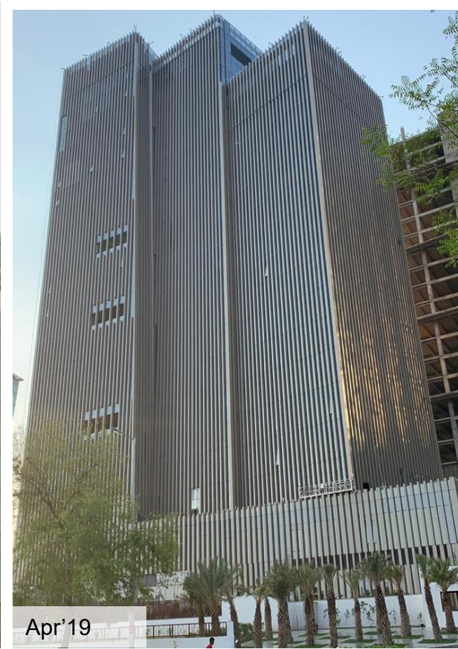
Actual site images of Max Towers
