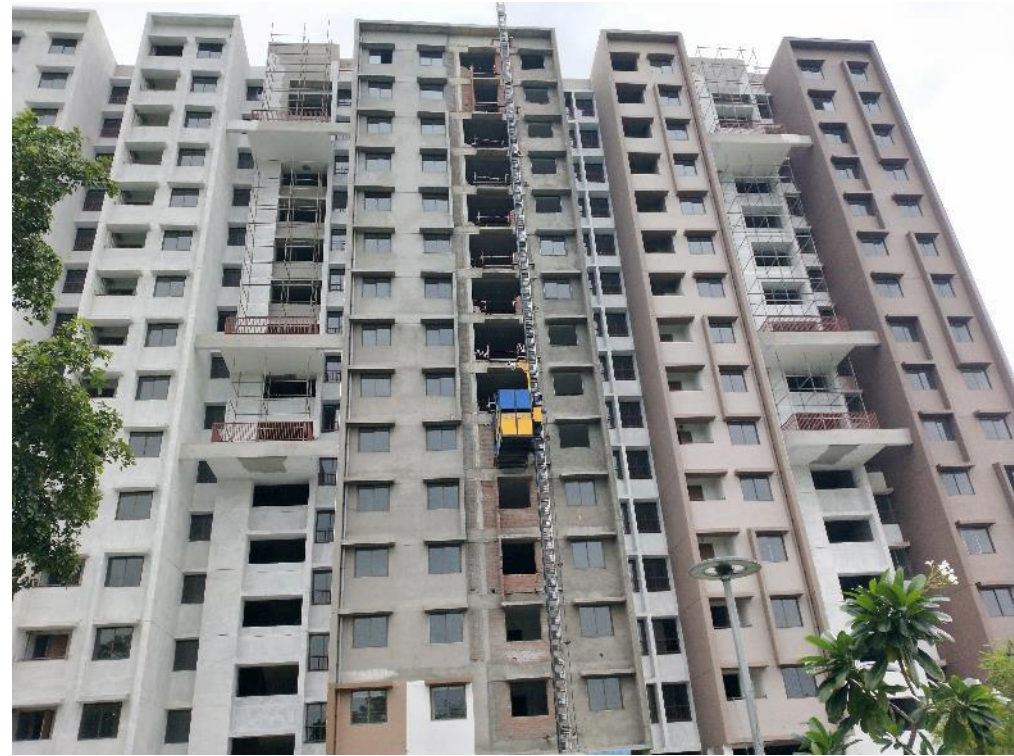
Actual Construction Images
