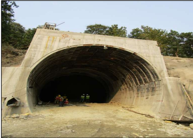
Sivok-Rangpo Tunnel, RVNL, Sikkim
