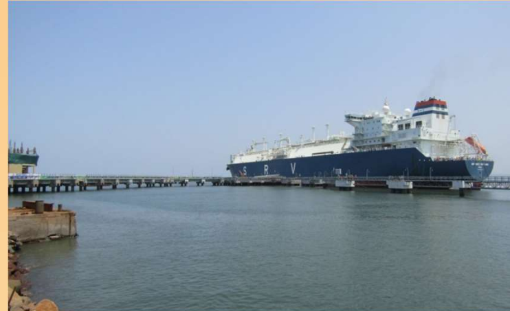
LNG Terminal for H-Energy, Raigad
