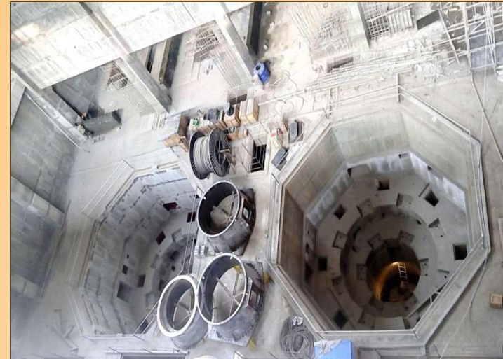
New Umtru H E Project
