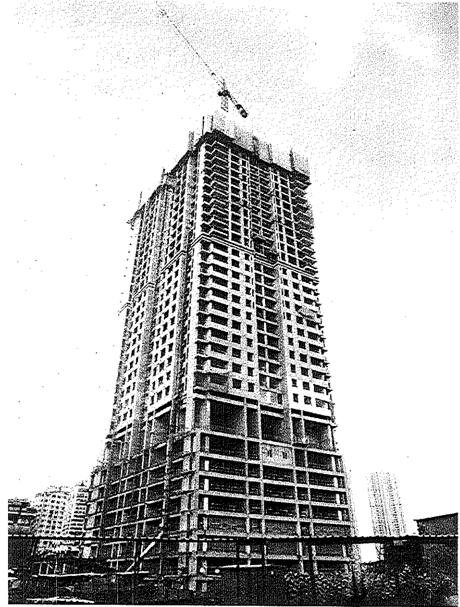
Actual Image - Construction Site
