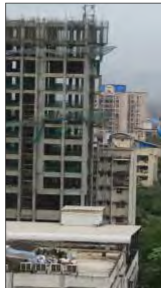
Actual Images - Construction Site
