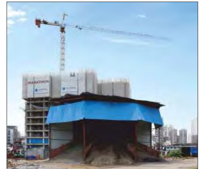
Actual Images - Construction Site
