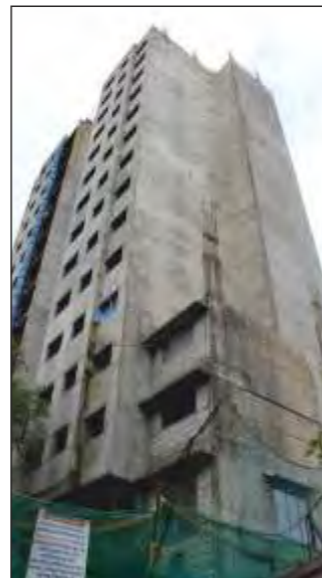
Actual Images - Construction Site
