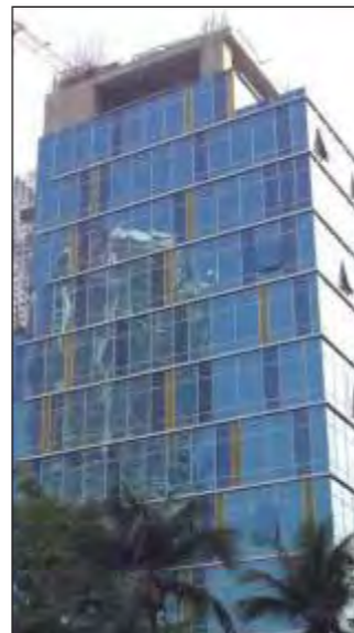
Actual Images - Construction Site
