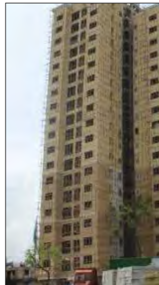
Actual Images - Construction Site
