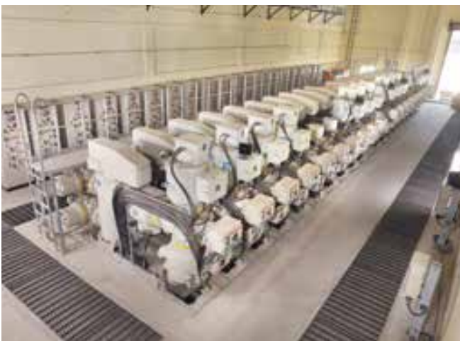
► 110 kV GIS Substation
