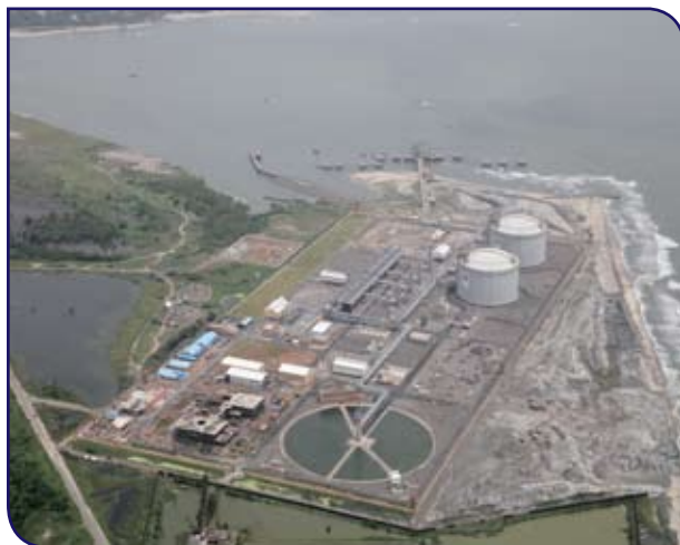
Kochi LNG Terminal
