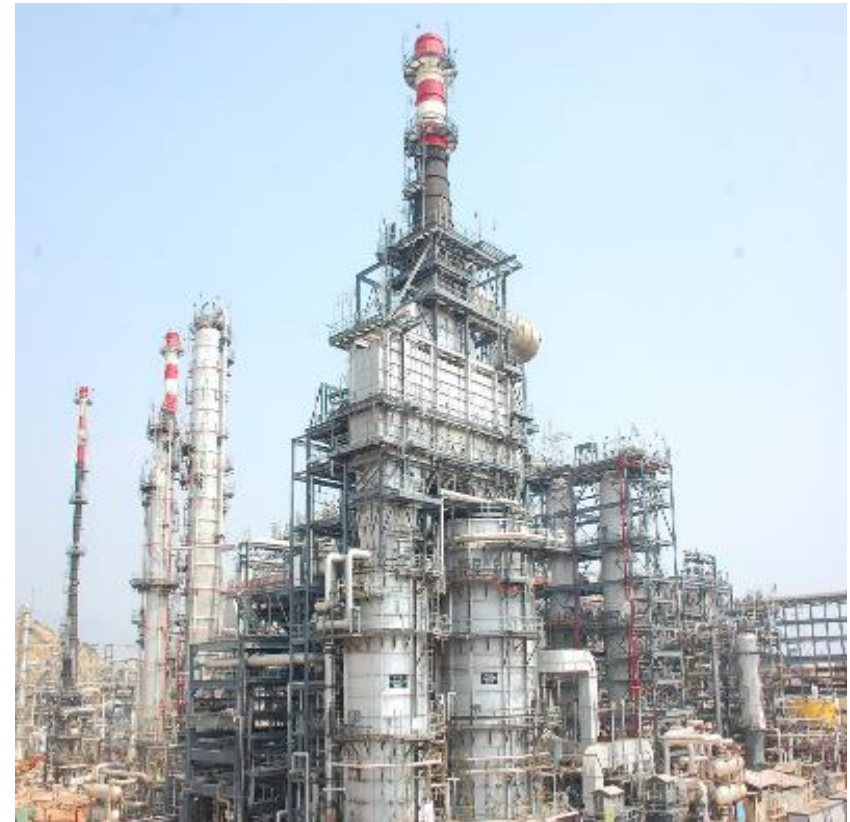
Visakh Refinery - 1.32 MMTPA
